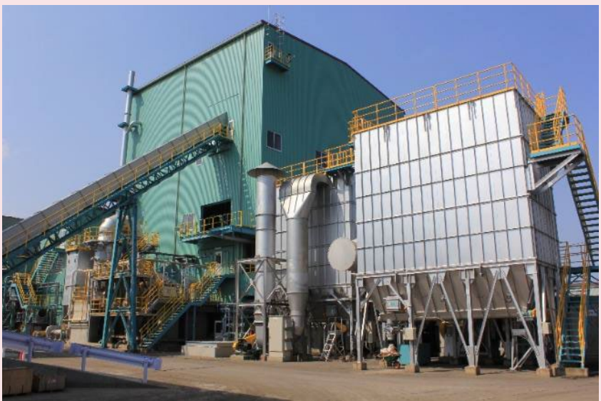
鹿島工場 灰溶融炉建屋
