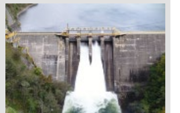
幌満川水力発電所
