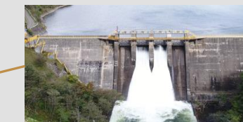
幌満川水力発電所
